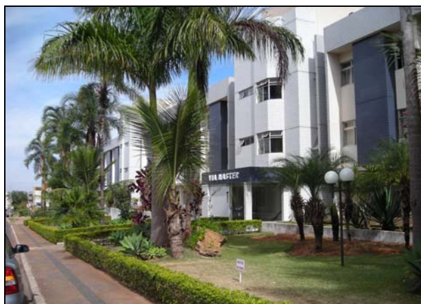
Foto 20 - QMSW 4 - Edificações utilizadas para uso residencial
