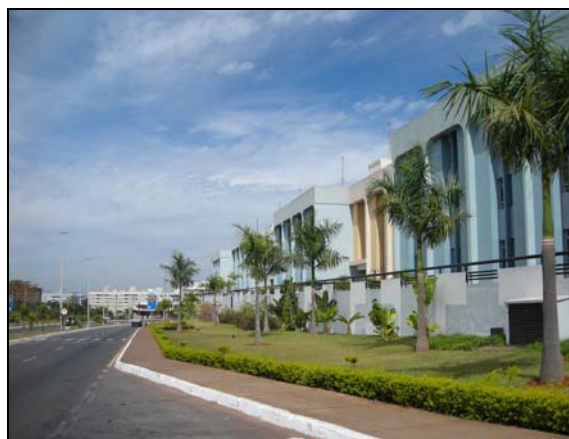
Foto 23 - QMSW 6 - Edificações utilizadas para uso residencial
