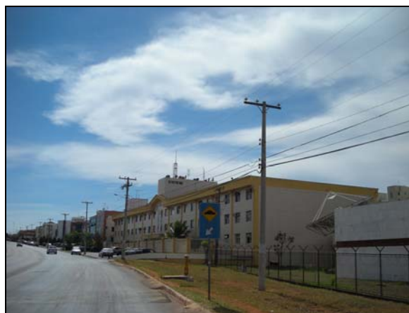
Foto 21 - QMSW 6 - Edificações utilizadas para uso residencial
