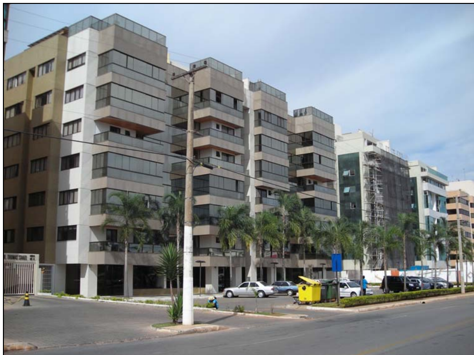
Foto 5 - Edificação do Centro Comercial - CCSW - altura 21,00 m
