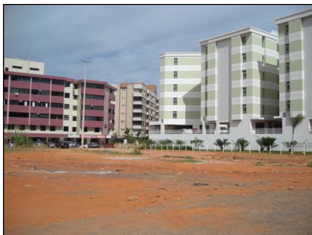
Foto 55 - Praça prevista em projeto delimitada por edificações e vias
