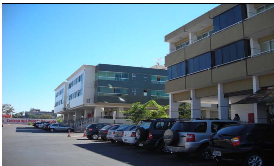
Foto 10 - Edificação do comércio local da SJSW 300 - 3 pavimentos e galeria
