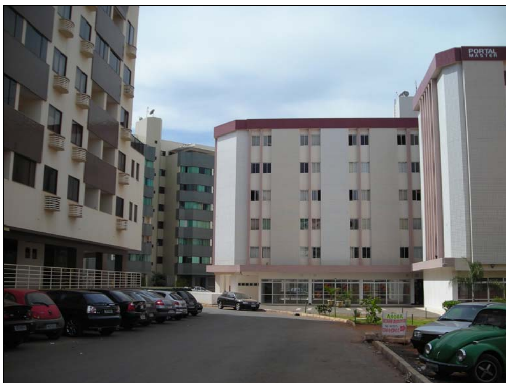
Foto 6 - Edificação do lote 4 do Centro Comercial - CCSW - altura 17,50m
