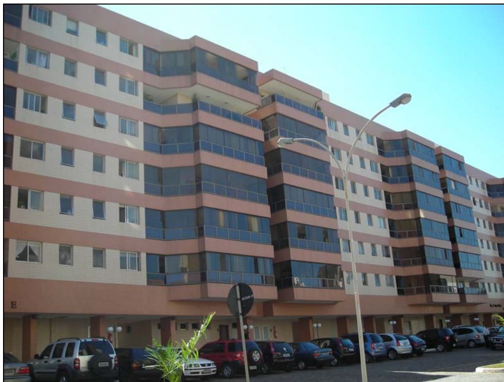
Fachada de bloco residencial com varanda na sala
