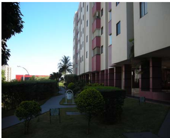
Foto 48 - Cerca viva delimitando o pilotis
