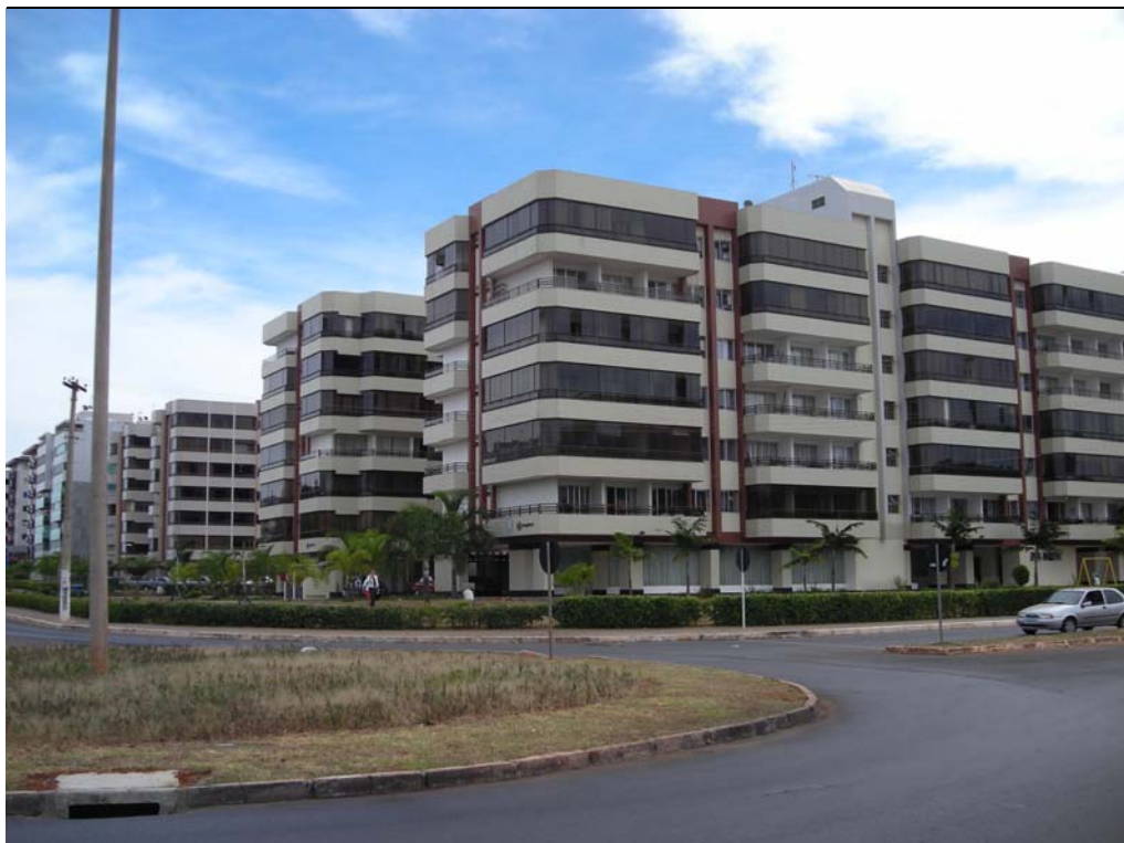
Foto 11 - Fachadas dos blocos residenciais das Superquadras com varandas e expansões de compartimentos
