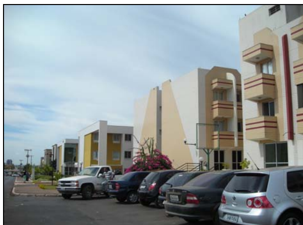
Foto 22 - QMSW 5 - Edificações utilizadas para uso residencial
