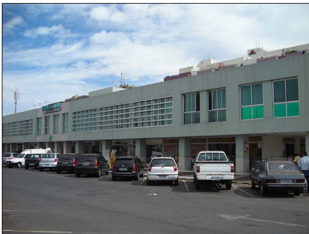
Foto 8 - Edificação da Quadra Mista - QMSW 6 - 2 pavimentos
