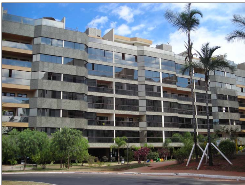
Foto 2 - Edificação de Superquadra - SQSW - 6 pavimentos e pilotis
