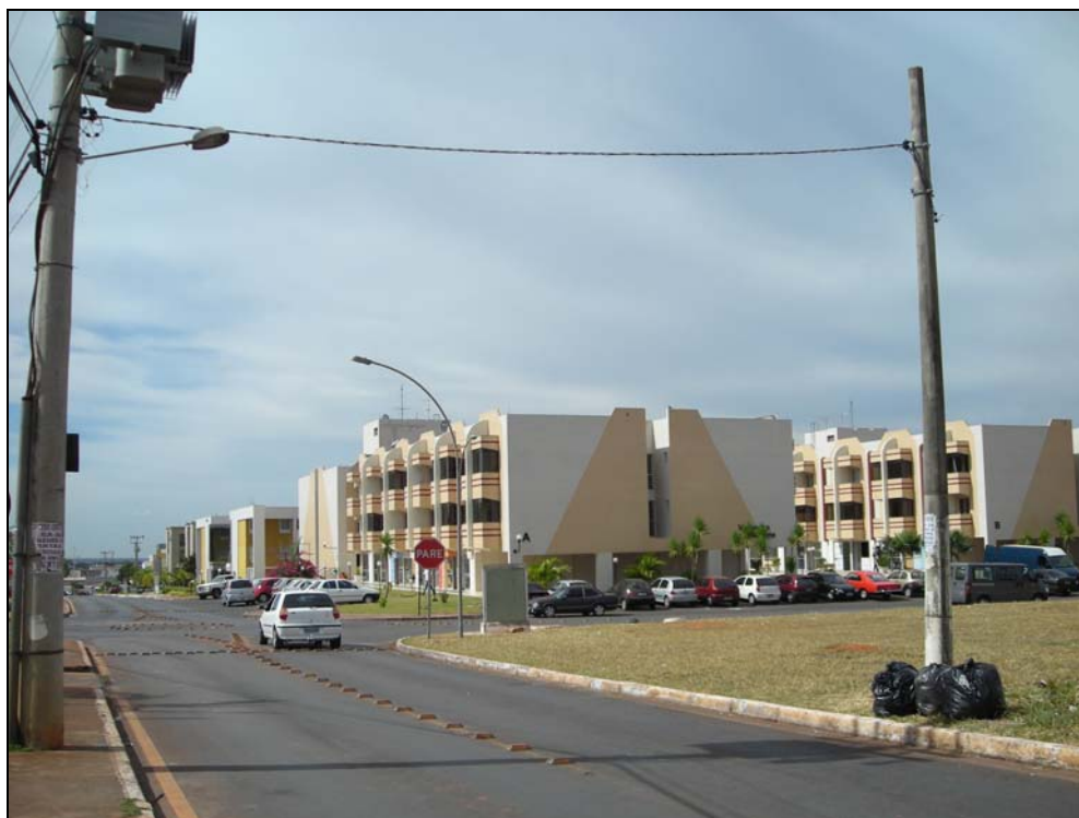
Foto 7 - Edificação da Quadra Mista - QMSW 4 e 5 - 3 pavimentos
