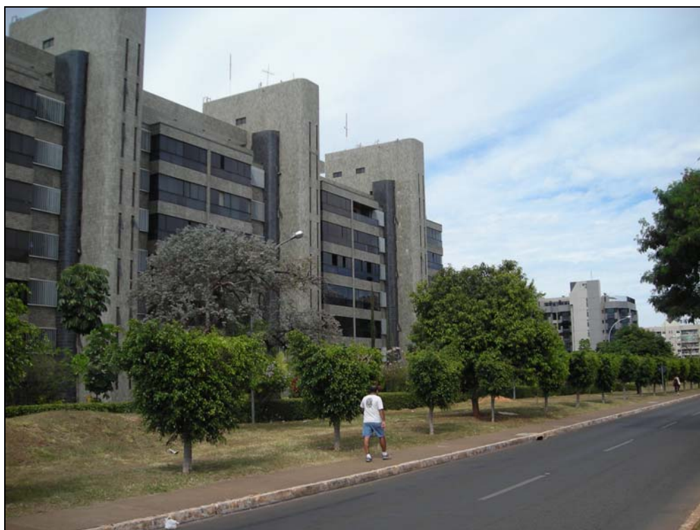
Foto 12 - Fachada de bloco residencial de Superquadra com torres de circulação vertical
