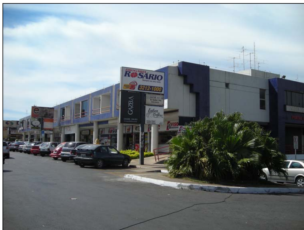
Foto 4 - Edificação do Comércio Local - CLSW - 2 pavimentos e galeria
