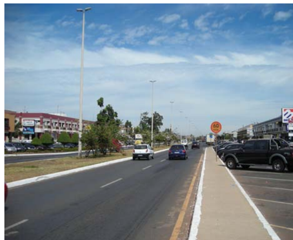
Foto 33 - 1ª Avenida, na altura da SQSW 303, com lotes comerciais e estacionamentos
