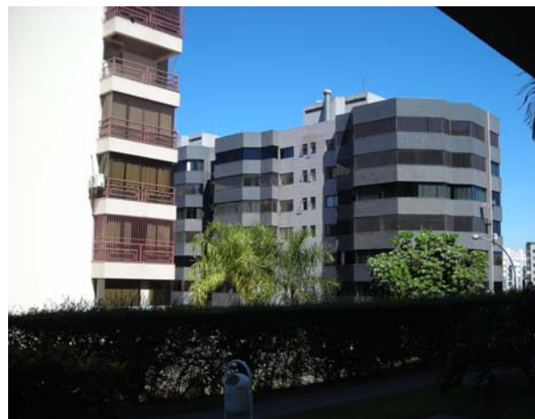
Foto 49 - Cerca viva delimitando o espaço referente à edificação
