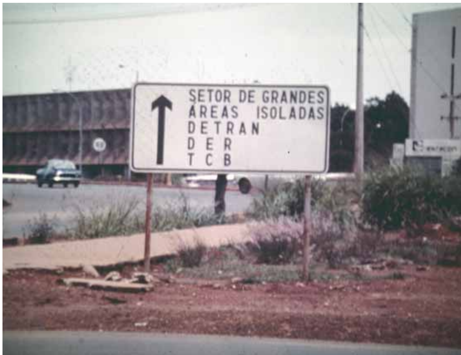
foto 106 Sinalização do Plano piloto em 1975, Via no Setor de Garagens Norte. Fonte: Antonio Danilo.
