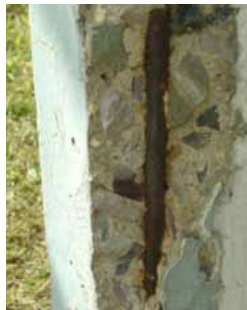
foto 167 Detalhe da peça e seus materiais construtivos que mais se apresentam com concreto.
