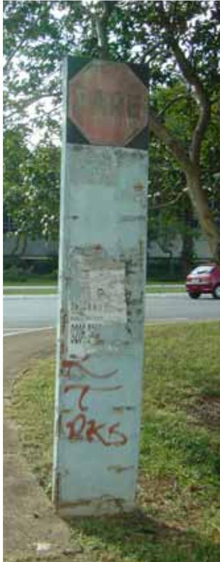
foto 165 Peça construída com tecnologia de concreto. Após 30 anos ainda se mantém em bom estado apesar da escoriações.
