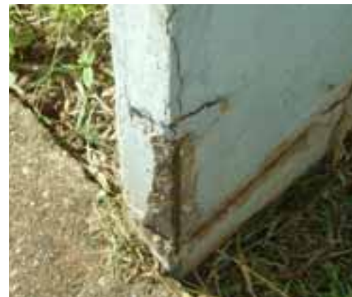
foto 166 A base com escoriações, provavelmente pelos mini-tratores cortadores de grama.
