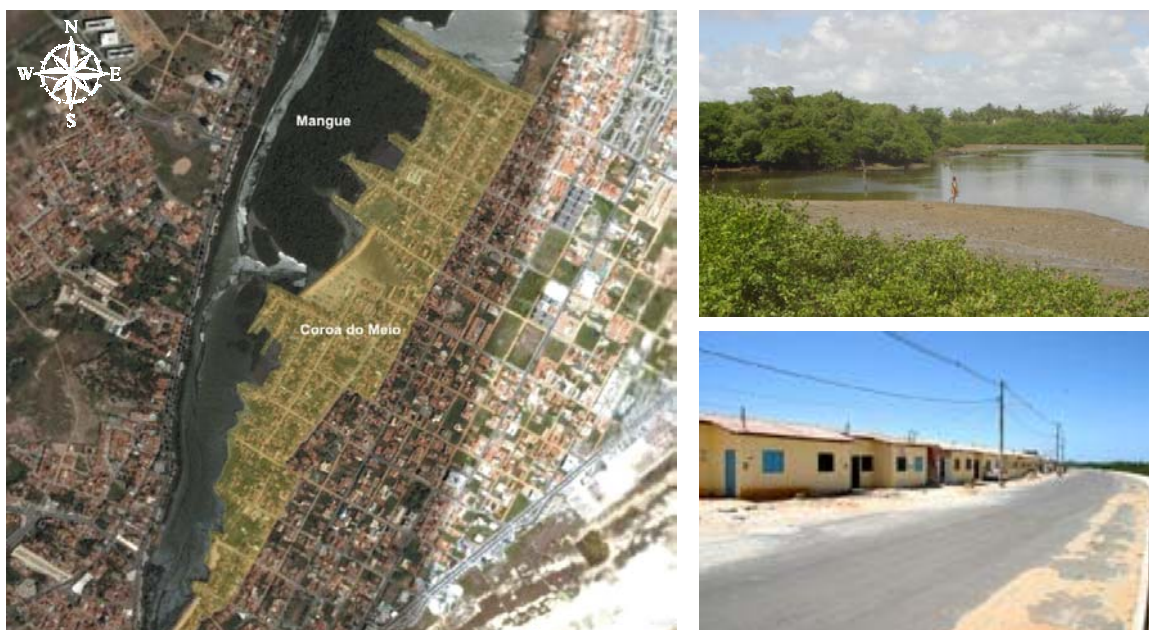
Figura 16 (à esquerda) – Vista do assentamento Coroa do Meio, em Aracaju, e APP adjacente (mangue). Fonte: DigitalGlobe, 2005, adaptado pela autora.
