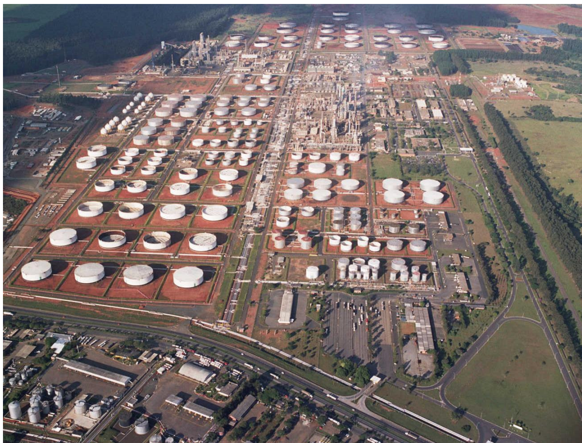
Figura 4.1 – Vista aérea da refinaria de Paulínia
