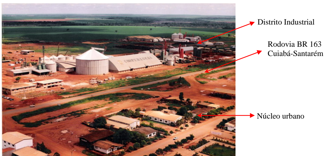
Foto 1: Vista área do núcleo urbano de Lucas do Rio Verde. No destaque a rodovia BR 163 Cuiabá-Santarém, o núcleo urbano e o distrito industrial. Ano 1994. (Acervo da Cooperlucas).
