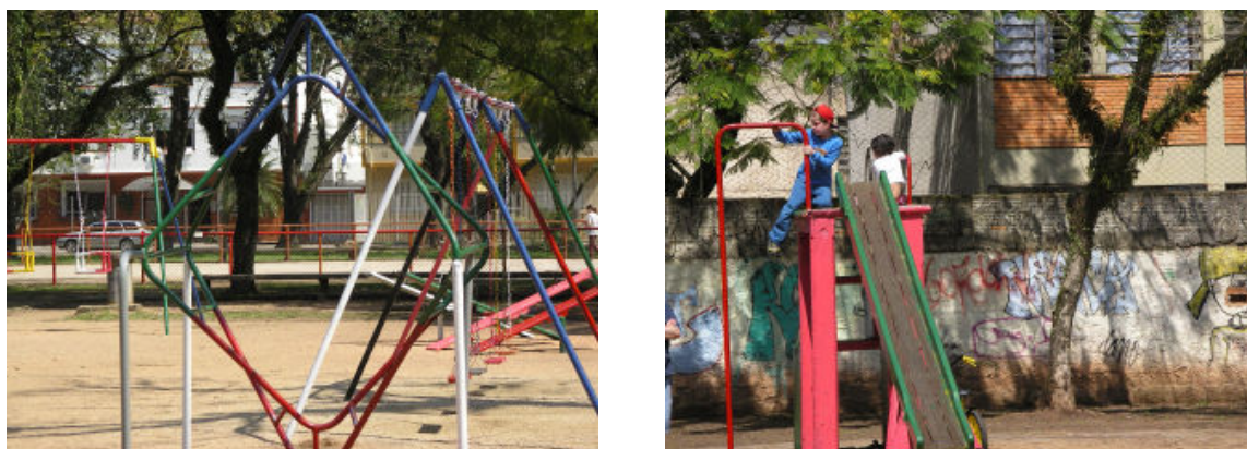
Figura 64: praça Estado de Israel: mobiliário existente
