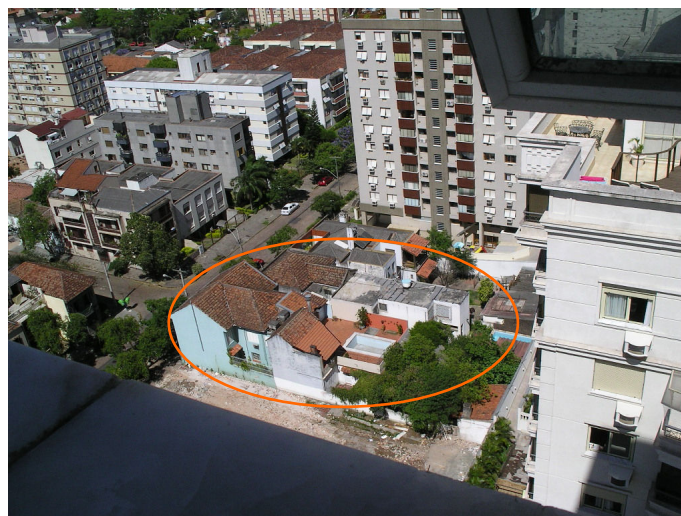
Figura 42: conjunto de edificações a ser demolido para dar lugar a novo projeto
