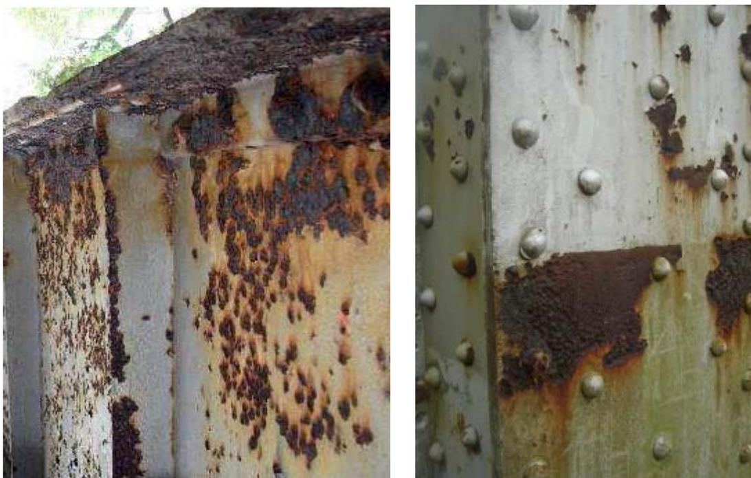
Figura 3.9: Corrosão na Ponte Hercílio Luz
