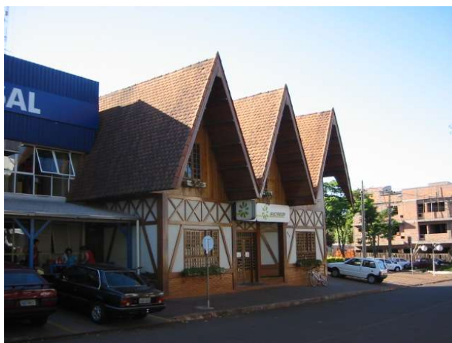
Figura 12 – Construção em enxaimel
