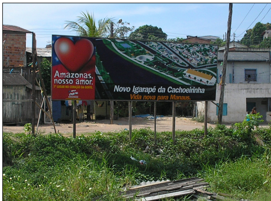
Figura 01: Início da obra no local, trecho rua Codajás, 2005. Foto: Sandra Lineia.
