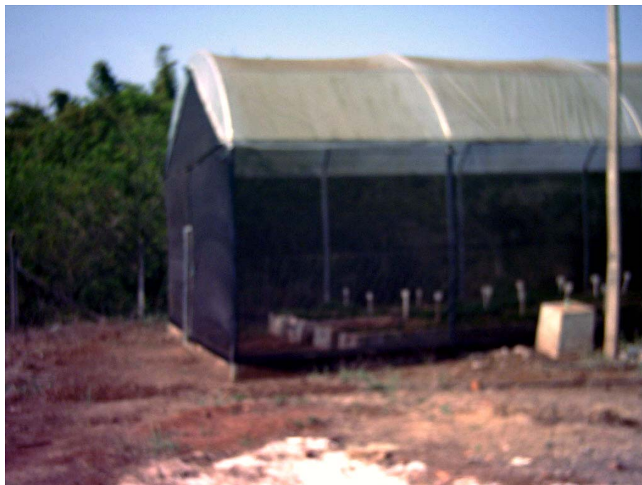
Figura 1. Vista da estufa da estação de tratamento de esgoto do lageado.
