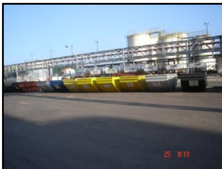
Figura 8 – Acondicionadores da área de desfibração e aditivos - capacidade 5m 3 .
