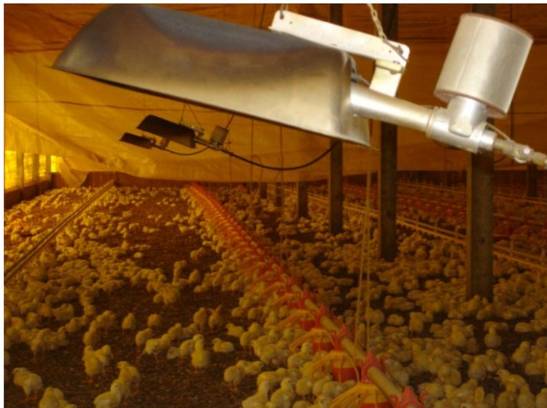
**Figura 12** Sistema de aquecimento automático infravermelho a gás utilizado.
