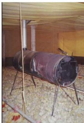
**Figura 4** Queimadores a lenha para suplementar o aquecimento proporcionado pelas campânulas a gás.
