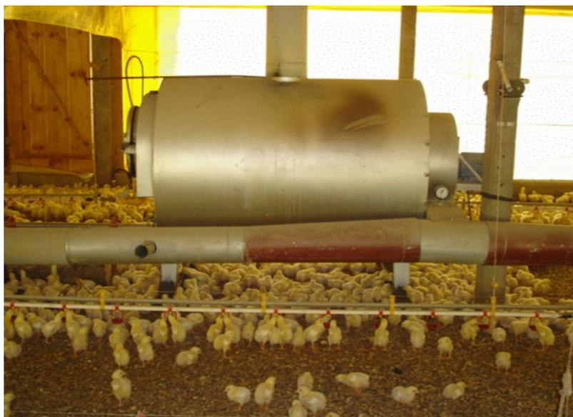
**Figura 11** Sistema de aquecimento automático a lenha utilizado.
