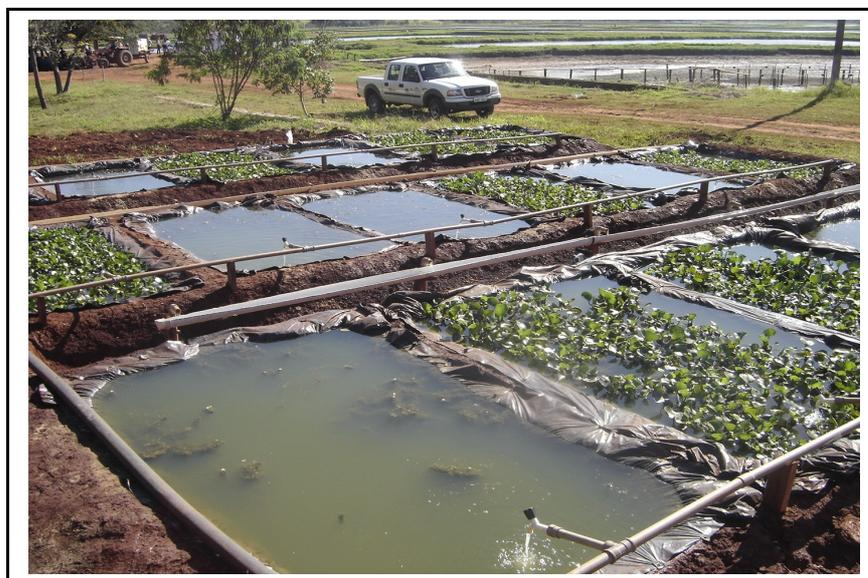
**Figura 5 -** Estrutura de tratamento em operação.
