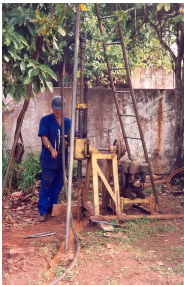
Foto 2.5. Execução de furo de sondagem rotativa para recuperação de testemunhos dos arenitos da Formação Botucatu, em Camapuã (MS).
