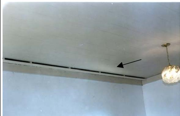
f – Vão de ventilação com arremate
