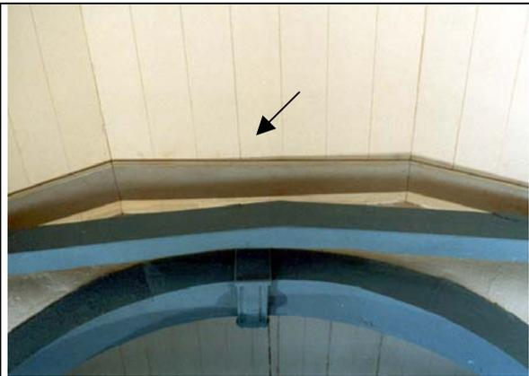
d – Vão de ventilação com arremate
