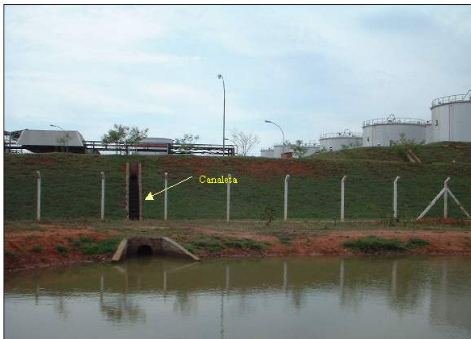
Figura 3.2. Foto da lagoa mostrando a canaleta e o bocal de descarga do efluente na mesma.
