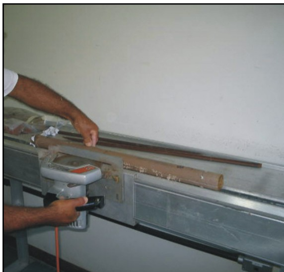
FIGURA 11. Abertura dos tubos de PVC com serra.
