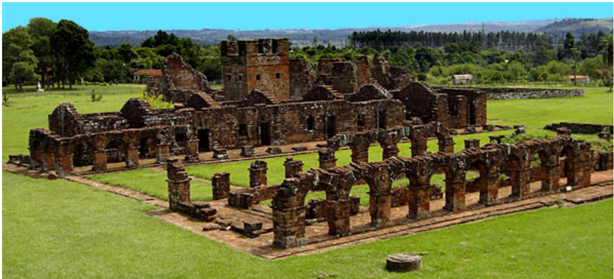
Figura 2 - Ruínas de São Miguel das Missões
