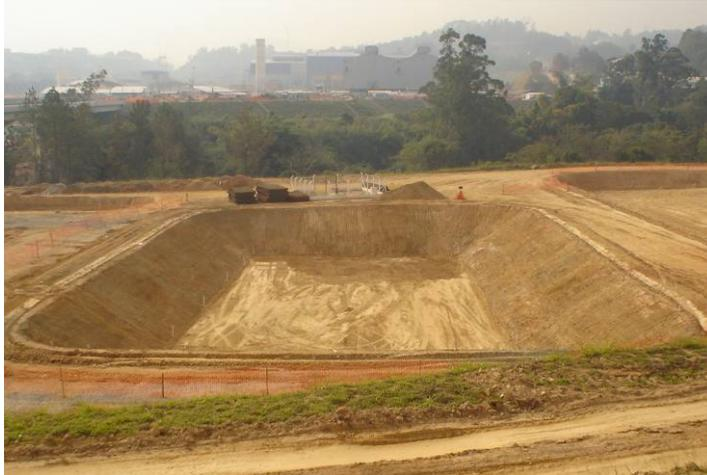
**Figura 3.13-** Camada impermeabilizante de solo-bentonita finalizada - Obra: Terramoto Gerdau (Fonte: Comunicação pessoal - GOUVEIA, 2005).
