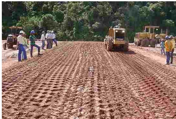
**Figura 3.12-** Compactação da camada de solo-bentonita - Obra: Camargo Solvay (Fonte: Comunicação pessoal - GOUVEIA, 2005).
