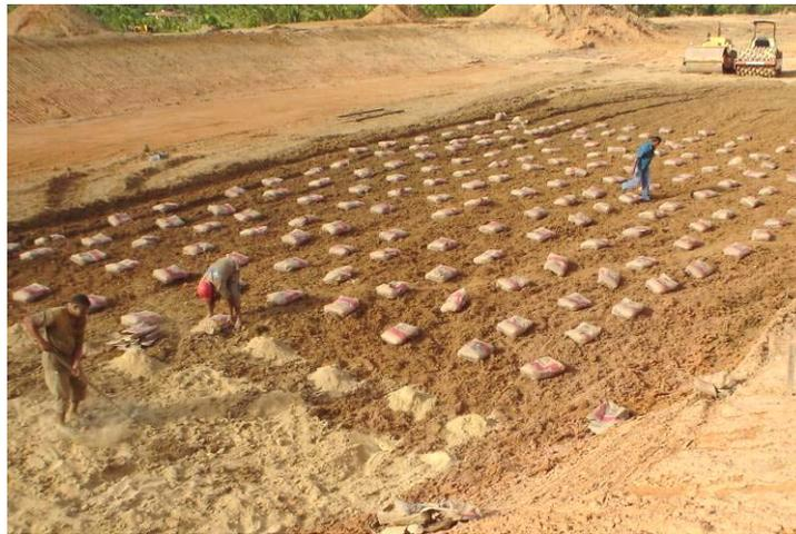
**Figura 3.11-** Execução da mistura de solo-bentonita manual – Obra: Serquip (Fonte: Comunicação pessoal - GOUVEIA, 2005).
