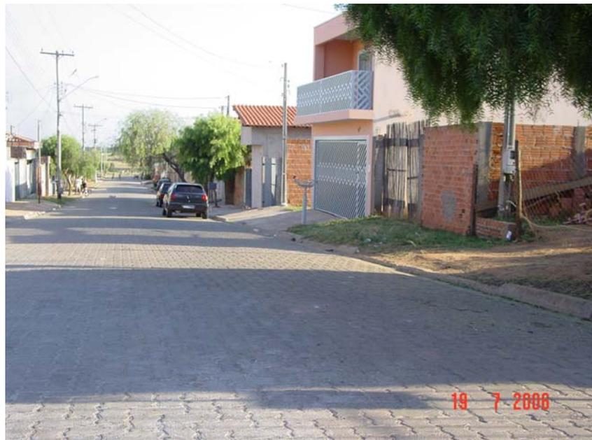
Figura 8. Pavimentação realizada com artefatos produzidos com RCD-R beneficiado na URESC.
