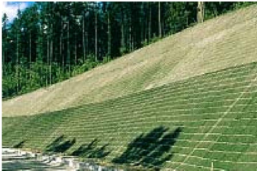
Figura 12. Estrutura de solo reforçado com vegetação na face.
