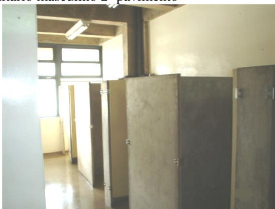
FIGURA 35 Box com placas de concreto sanitário masculino 2º pavimento
