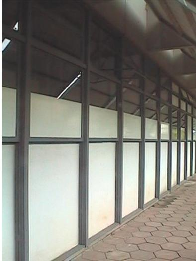
FIGURA 29 Esquadria externa - módulos de espaçamento de 1,24m
