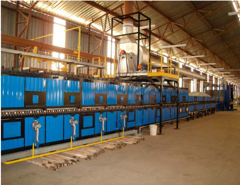
Figura 17. Futuras instalações da Cerâmica Fornari (argilas brancas), indústria integrante do APL situado no Município de Rio Verde de Mato Grosso, Mato Grosso do Sul
