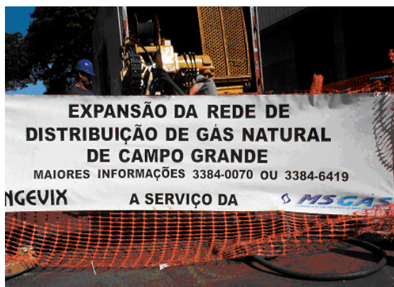
Figura 18. Faixa de comunicação para a comunidade do Bairro sobre a Expansão da Rede de Distribuição de Gás Natural
