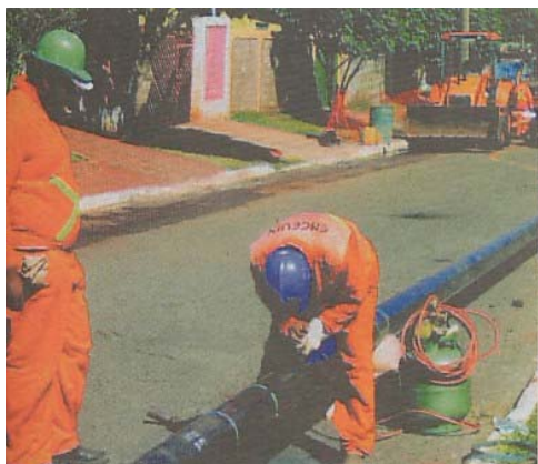
Figura 19. Instalação da rede de distribuição do gás natural
