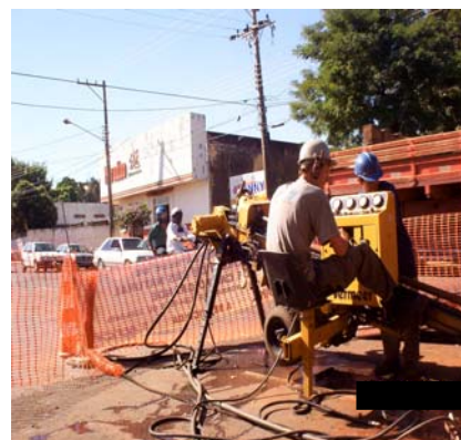
Figura 20. Supervisão da Instalação da rede de distribuição do gás natural
