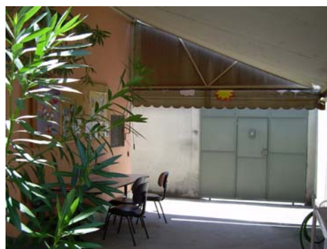
Fig. 31b – Vista sob o toldo no lado leste do PSF
