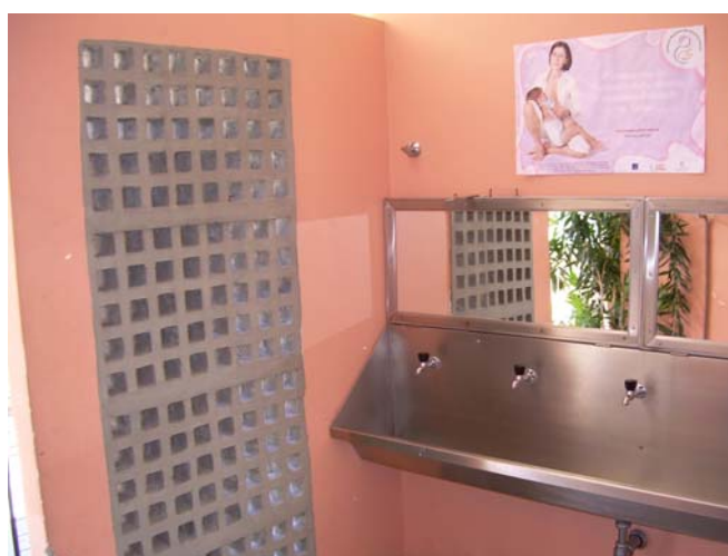
Fig. 35 – Vista do escovário de Jardim Anápolis ventilado e protegido da chuva lateralmente por um cobogó de concreto
