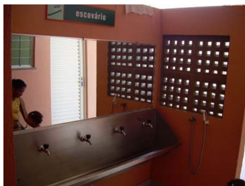
Fig. 56 - Vista do escovário ventilado e protegido da chuva lateralmente por um cobogó de concreto.
