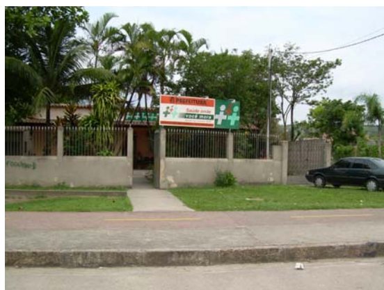
Fig. 16 – Vista da Fachada Principal e respectivo acesso. Elevação Oeste.
