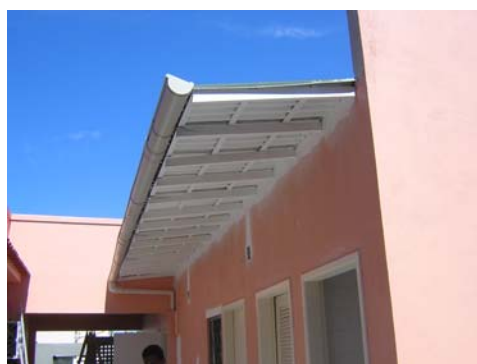
Fig. 34 – Vista do telhado durante a obra após receber pintura branca a base de PVA.
