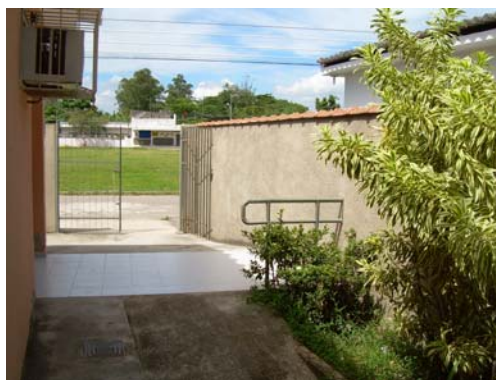
Fig. 63 – Vista do guarda corpo entre a rampa de acesso e o jardim do PSF, ao fundo o gramado da praça.
