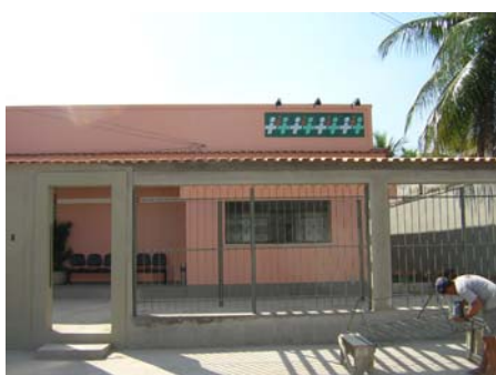
Fig. 30a – Vista da fachada principal oeste, com a substituição de parte do muro por grades.
