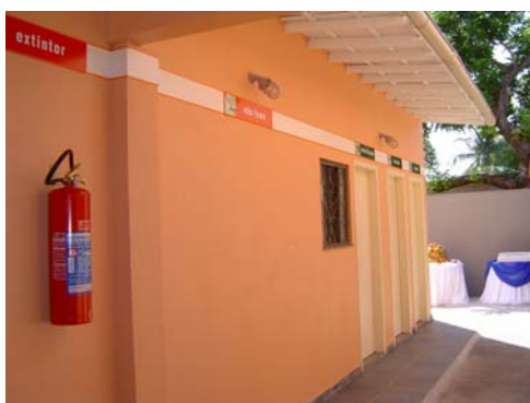
Fig. 33 – Vista interna do novo bloco do PSF com o beiral da telha ecológica em detalhe
