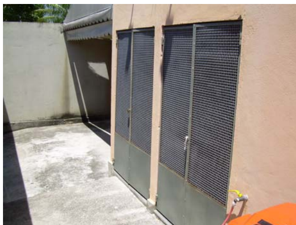
Fig. 32 – Detalhe do depósito de lixo com as duas células.
