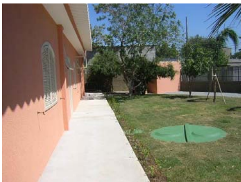
Fig. 54 – Vista da empena oeste onde se vê a platibanda original e sobre esta o beiral proporcionando sombra do sol da tarde.
