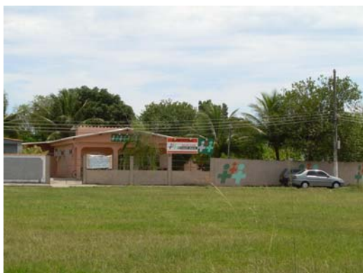
Fig. 46 – Vista da fachada principal do PSF tomada a partir do campo de futebol da praça.
