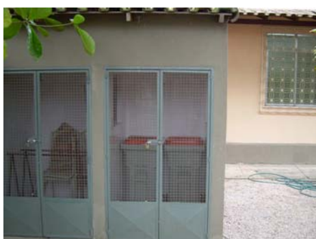
Fig. 19 – Vista externa do depósito de lixo onde se vê as portas com telas metálicas.
