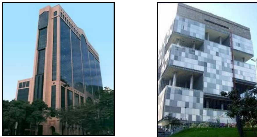
Figura 2 Contraste entre arquitetura não adaptada e outra adaptada ao clima do Rio de Janeiro – edifício RB1 e sede da Petrobrás, respectivamente.
