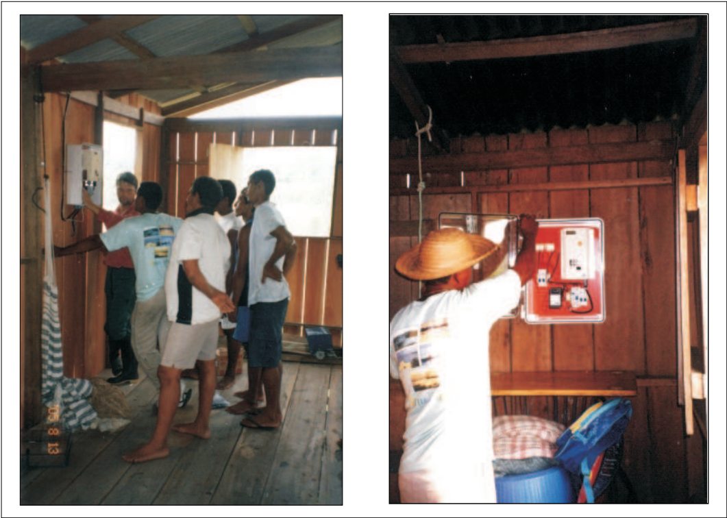
Figura 2.20: Montagem dos quadros elétricos dos SFDs.
