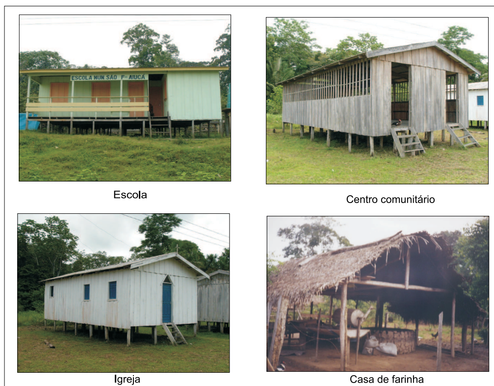
Figura 2.6: Construções comunitárias em São Francisco do Aiucá.
