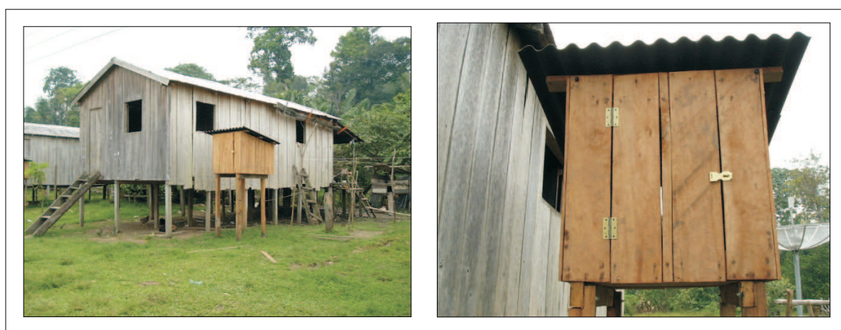
Figura 2.22: Abrigos para as baterias finalizados.
