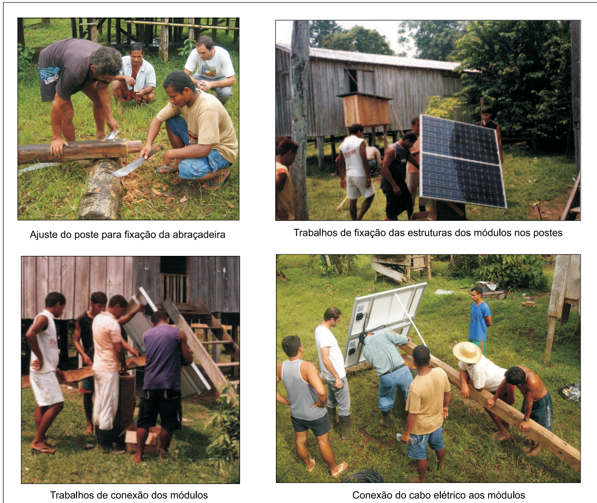
Figura 2.25: Fixação das estruturas nos postes e conexão dos cabos elétricos aos módulos.
