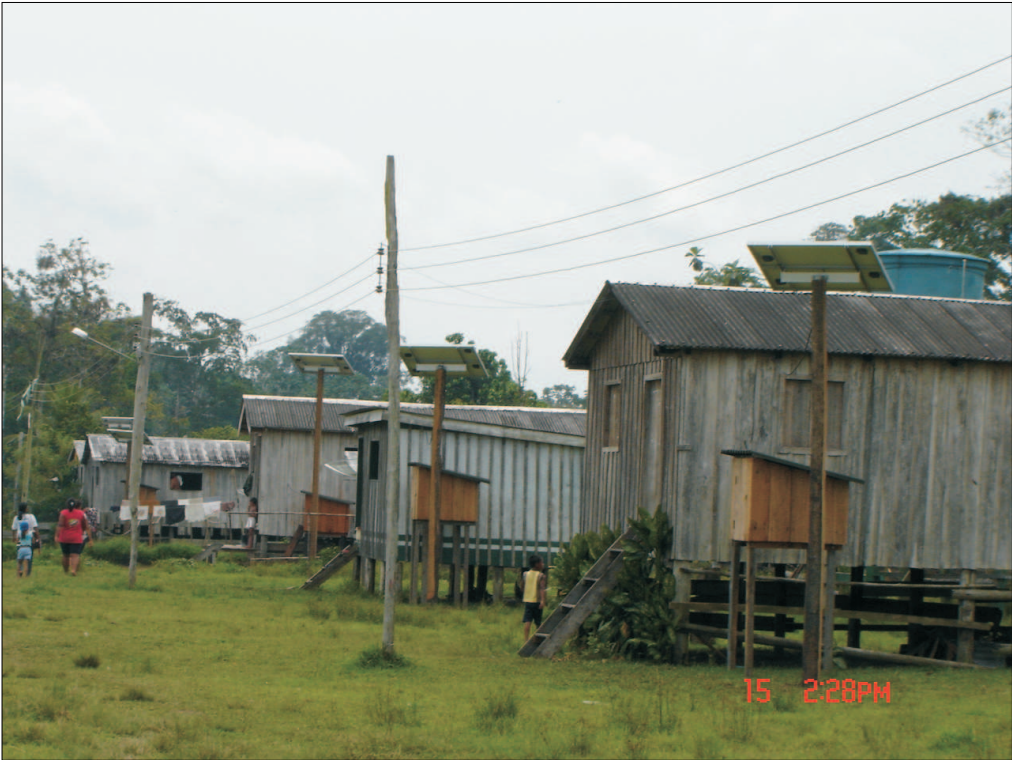
Figura 2.50: Vista da comunidade após a instalação dos SFDs.
