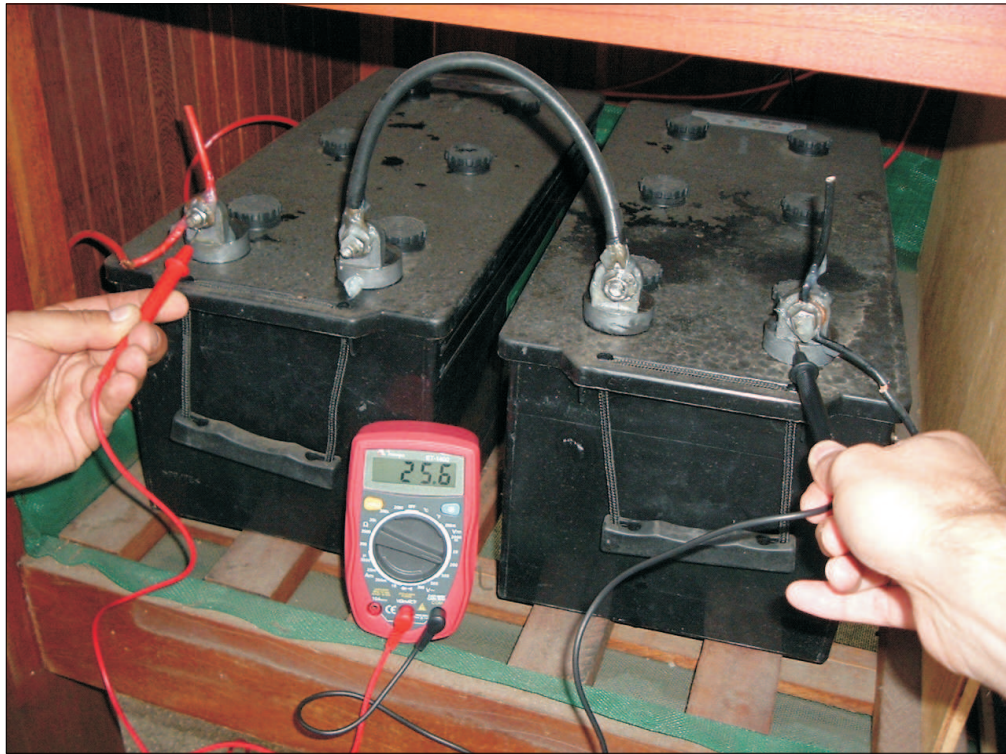
Figura 3.20: Medição da tensão da bateria.
