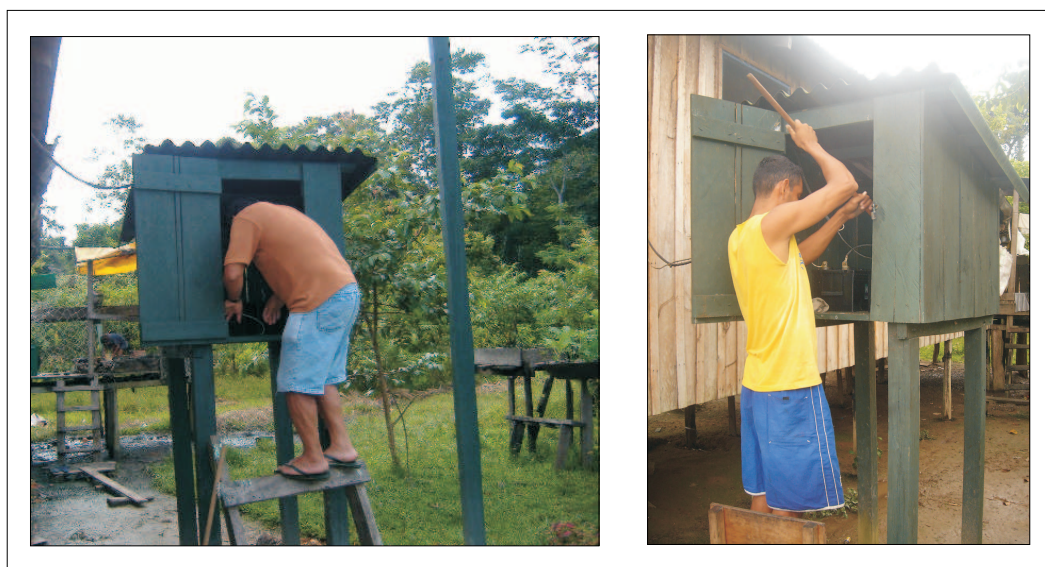
Figura 3.14: Manutenção preventiva nos abrigos de baterias.
