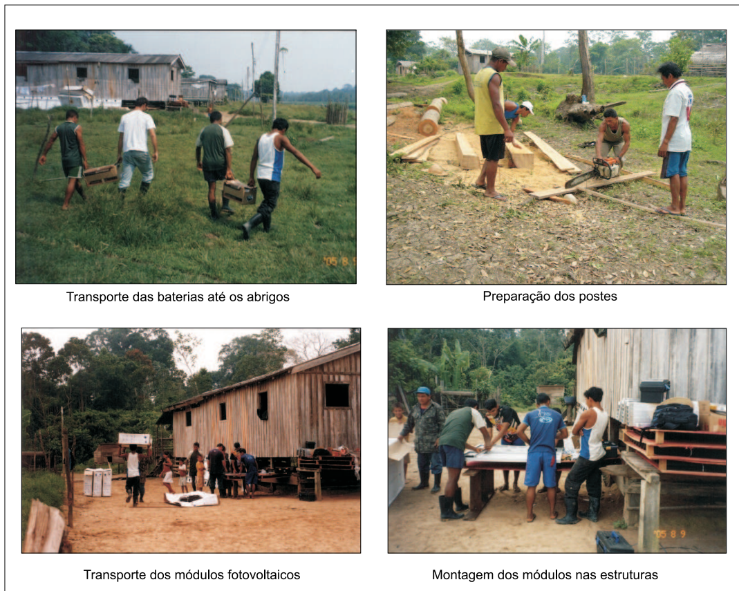
Figura 2.23: Transporte das baterias até os abrigos, preparação dos postes e colocação dos módulos nas estruturas.
