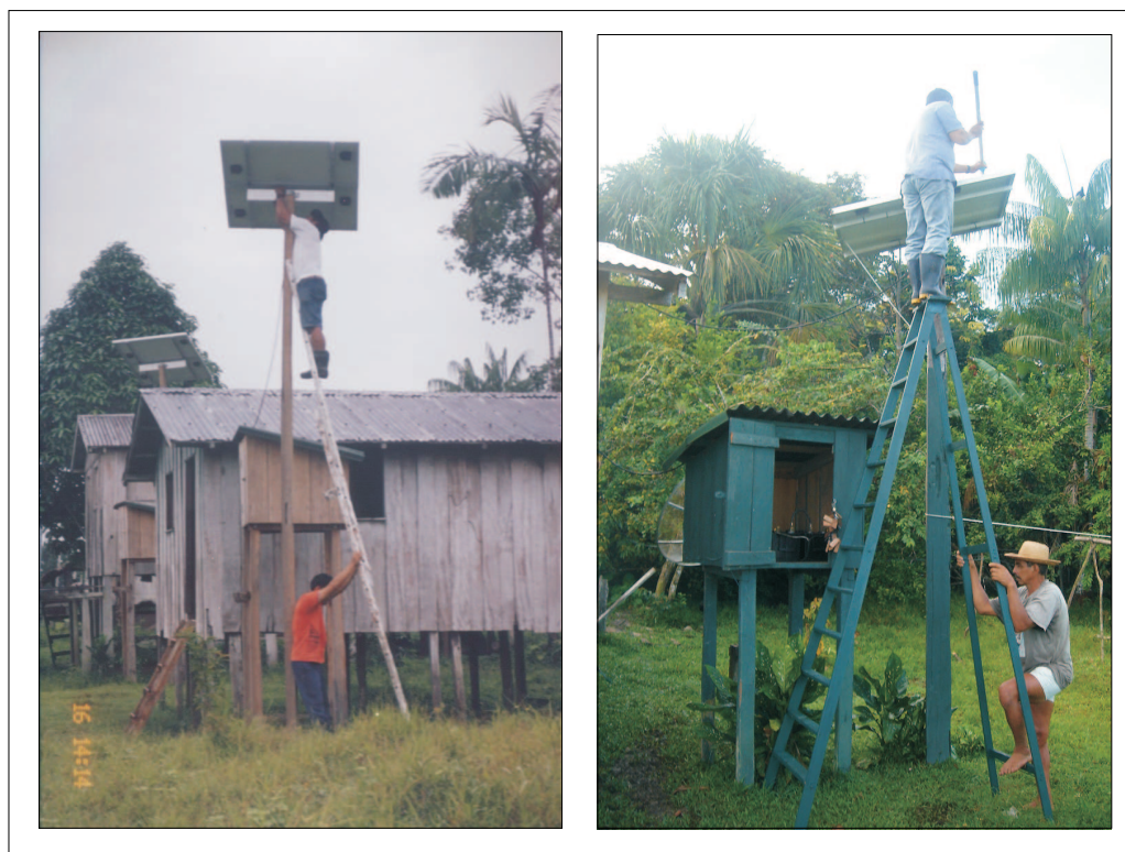
Figura 3.17: Inspeção visual e limpeza dos módulos fotovoltaicos.
