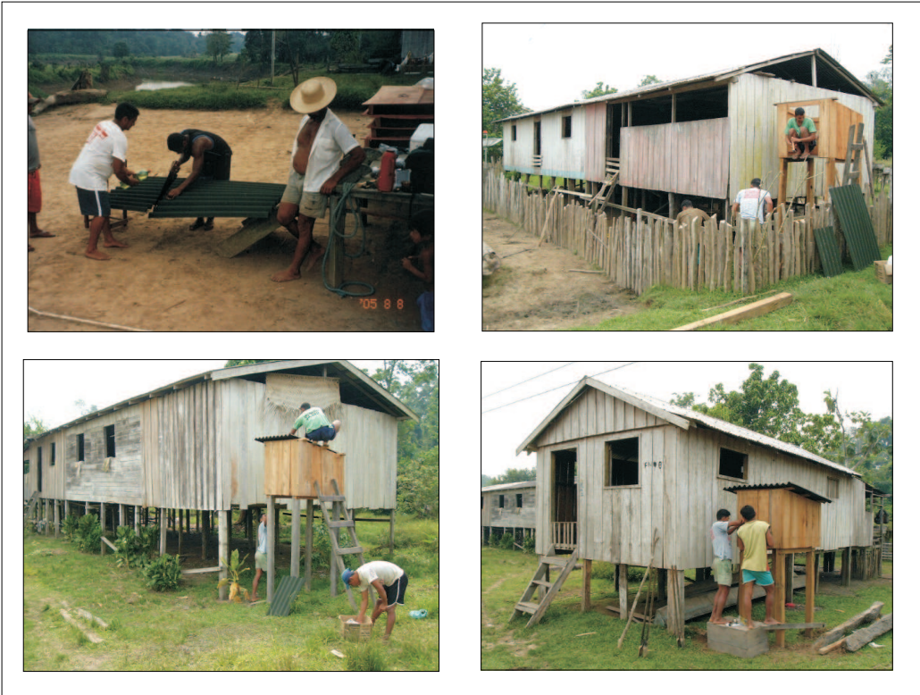
Figura 2.21: Construção dos abrigos para as baterias.
