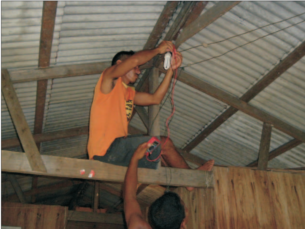
Figura 3.21: Medição da tensão nas instalações elétricas internas.
