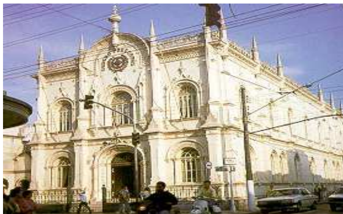
Edifício do Centro Português – Santos. Arquivo pessoal, 2005
