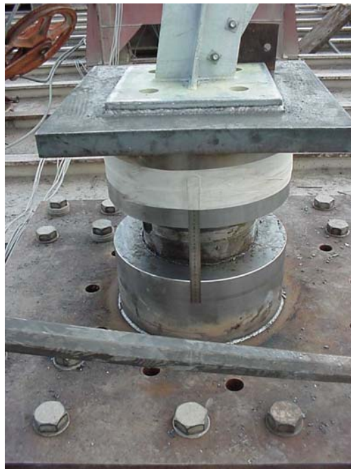
Figura 6.7: Medição dos deslocamentos impostos na base da torre “2”.
