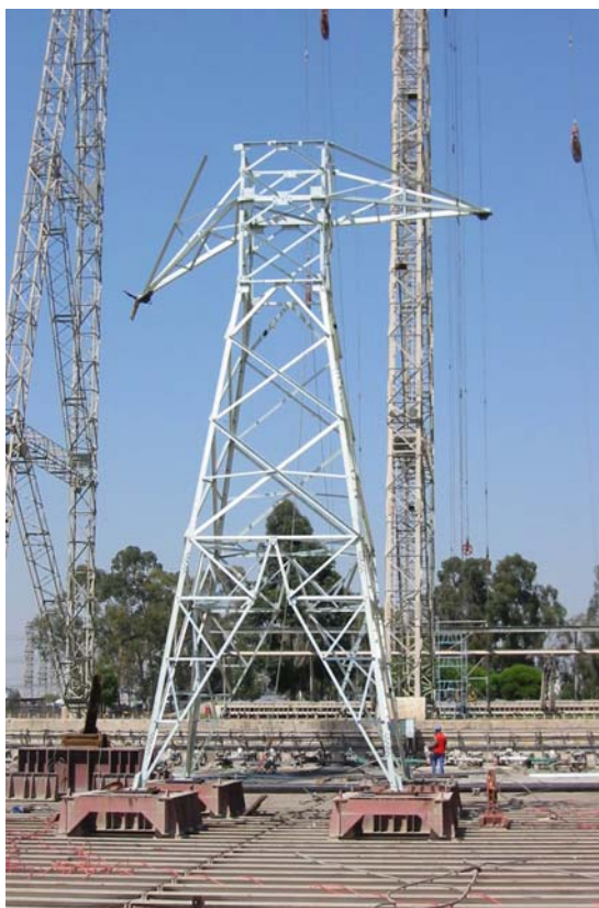
Figura 6.16: Torre “1” após o ensaio de ruptura.
