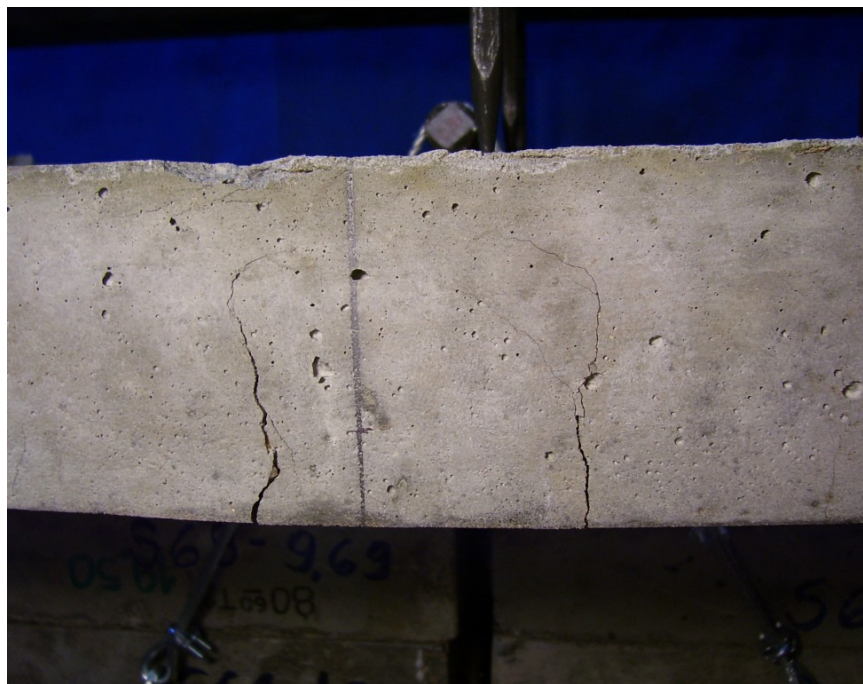
Figura 33: estado da viga V4 (96%) antes do carregamento permanente
