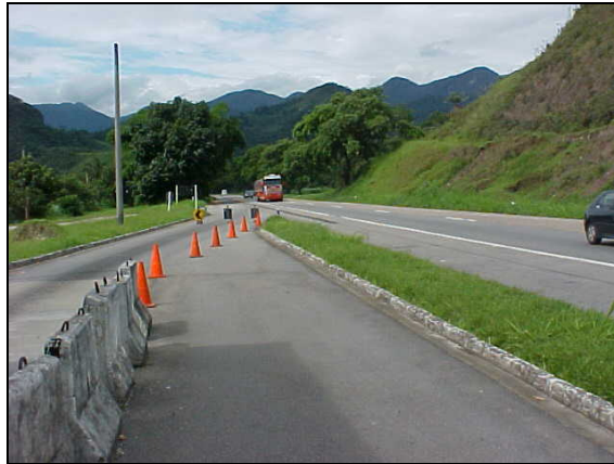
Figura III.4 - Pista lateral para pesagem de veículos, BR 040, Duque de Caxias.
