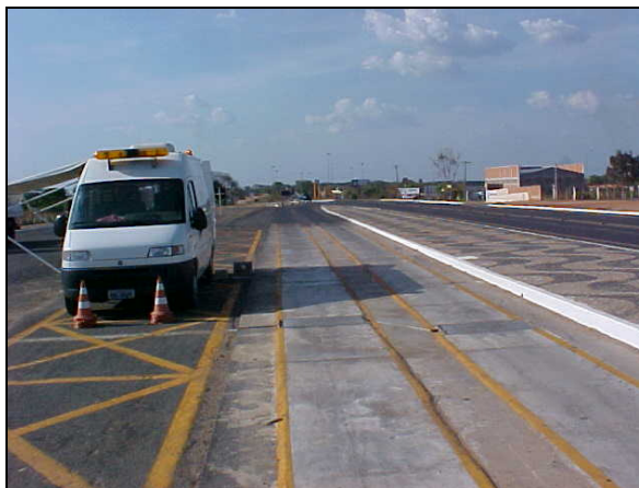
Figura III.8 - Posto de pesagem de veículos, rodovia BR-316, Teresina, PI.
