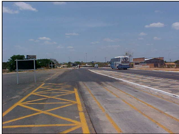
Figura III.5 - Local da realização de ensaios metrológicos - BR 316 – Piauí
