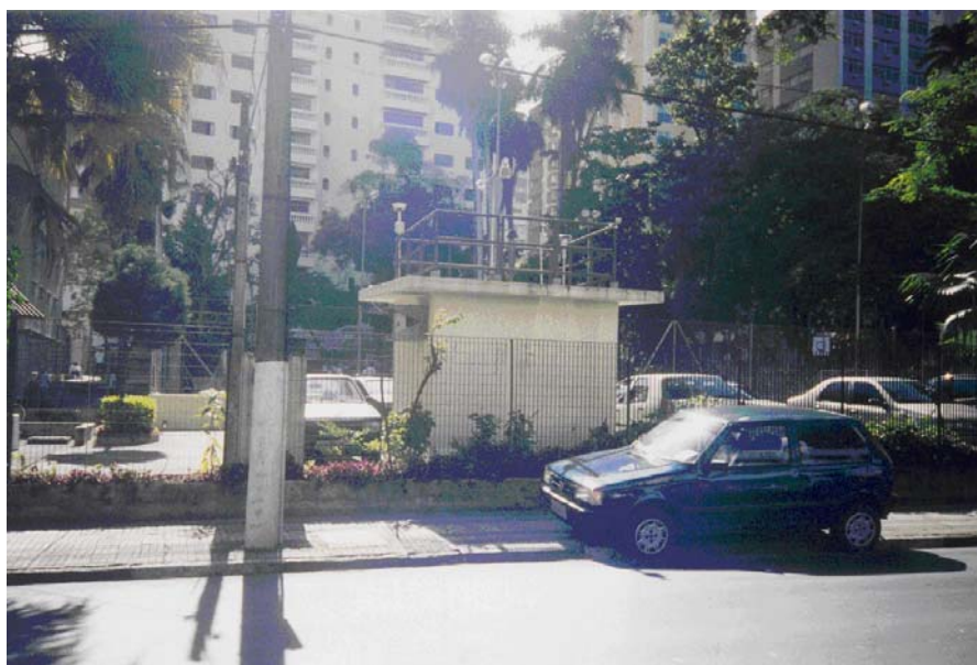
Figura 5.1 – Vista geral do posto instalado nas dependências da estação da CETESB em Campinas, localizado no estacionamento do colégio Carlos Gomes situado na avenida Anchieta.
