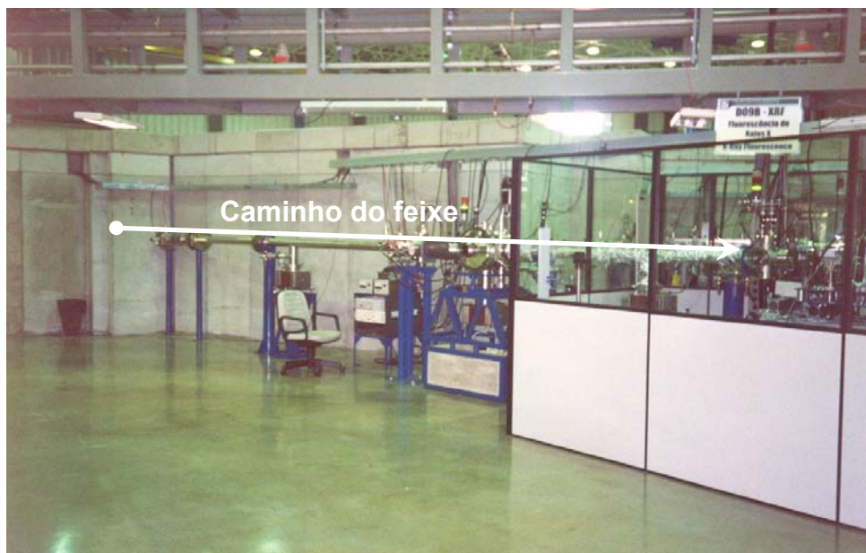
Figura 5.11 – Foto da tubulação do anel para a linha DO9B – XRF do Laboratório Nacional de Luz Síncrotron, por onde passa o feixe de luz síncrotron.
