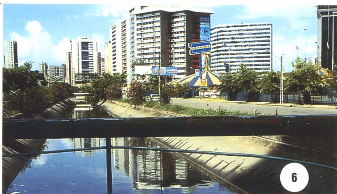
6 – verticalização e canal junto ao “shopping center”
