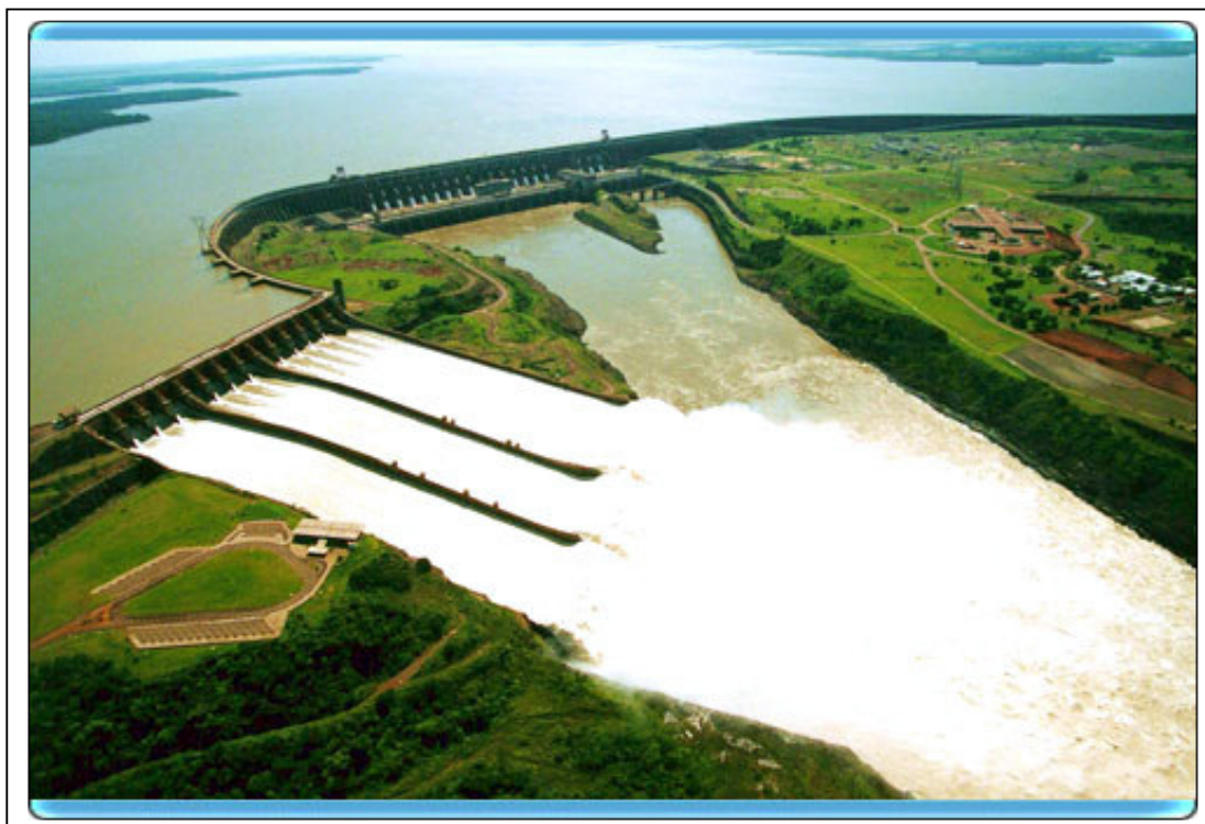
FIGURA 5 - FOTO DA REPRESA DE ITAIPU
