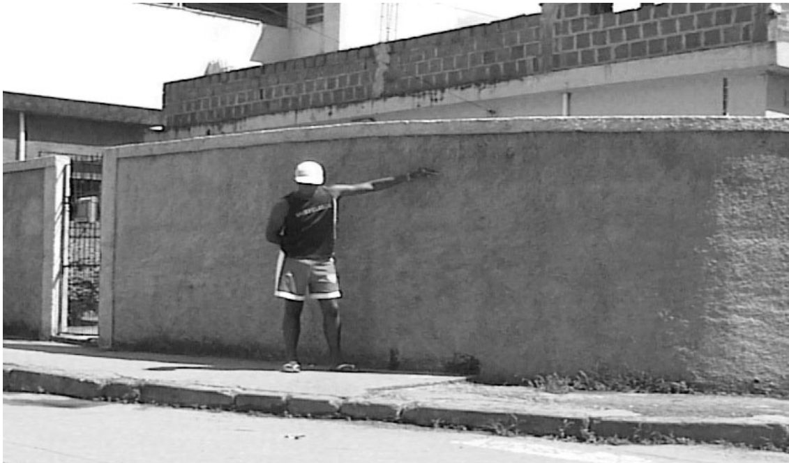
Figura 7.4 – Marca de inundação no Bairro Industrial.
