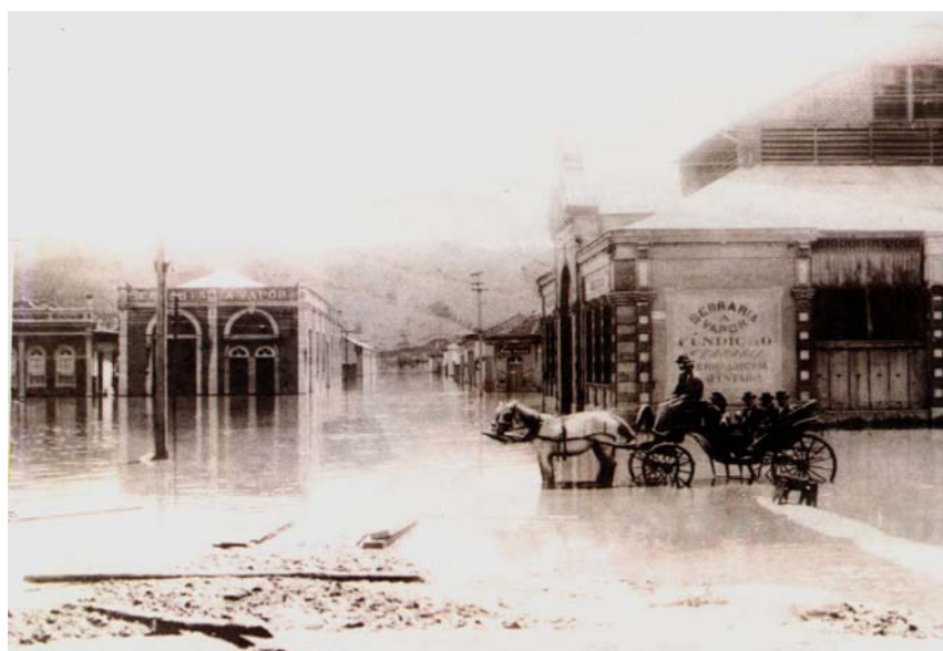
Figura 2.4 Rua São Sebastião. Centro de Juiz de Fora durante a enchente de 1906. Fotógrafo: Antenor Campos e Cia. (Acervo do MMP)
