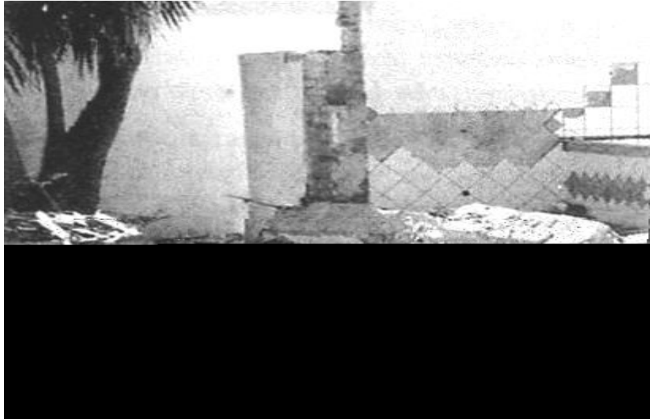
FIGURA 2 - Mistura de componentes construtivos do resíduo de construção e demolição pela ausência de gestão em demolições Fonte: Coletânea Habitare (2003)
