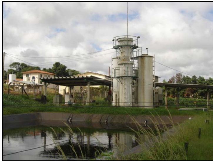
FIGURA 7. Vista Parcial do sistema piloto de tratamento da água residuária do
