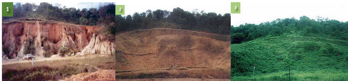
FIGURA 35 – Área recuperada por Bioengenharia
