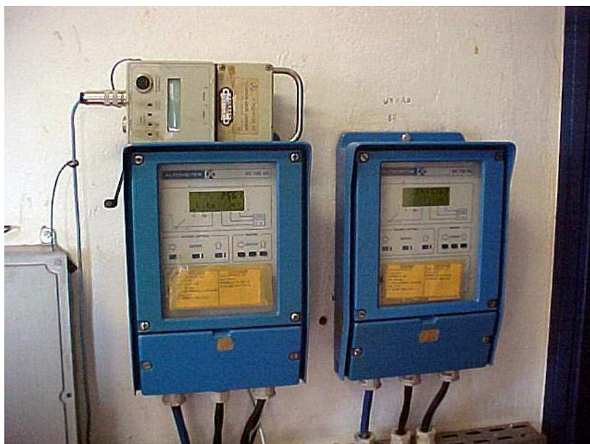
Figura 4.11 – Aquisição dos dados de vazão
