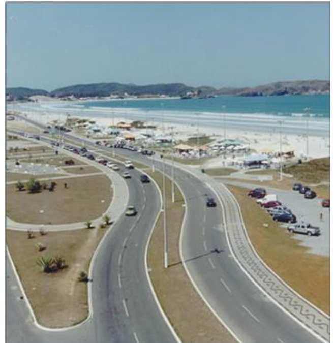
Figura 33: Avenida Cristóvão Colombo - já construída
