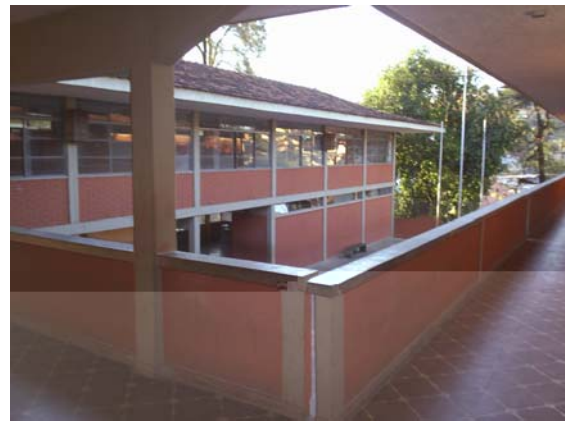
FIGURA 05: Circulação aberta das salas de aula e vista fachada que deveria ser orientada para Sul. FONTE: Levant. fotográfico realizado pela autora.
