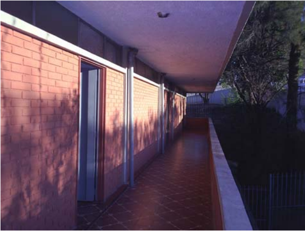
FIGURA 16: Vista circulação do bloco 01, sala da orientadora e salas 11 e 12 ao fundo. FONTE: Levant. fotográfico realizado pela autora.
