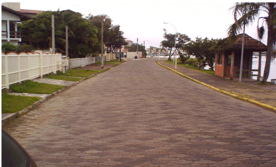
Figura 3: Via urbana com bloco intertravado de concreto (Maio/2005) – Foto do Autor
