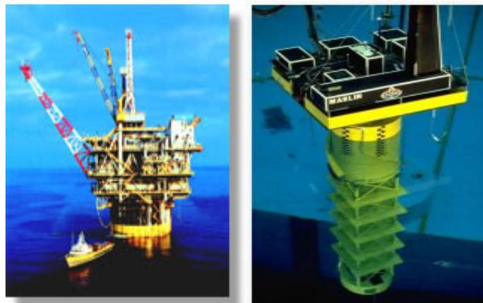
Figura 2-1 - Plataformas fixas (aço e concreto) e Plataformas flutuantes
