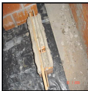
e) Colocação argamassa na longitudinal
