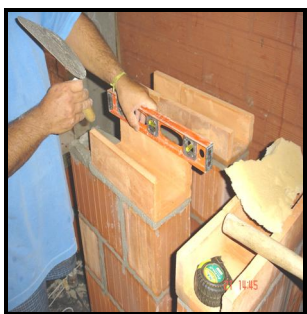
d) Colocação canaleta u
