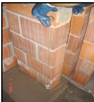
i) pequena parede sendo capeada
