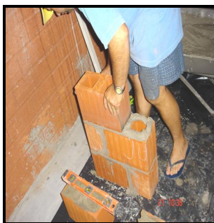
b) Execução da alvenaria
