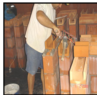
f) Colocação canaleta u
