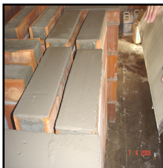
j) Capeamento sob a canaleta u
