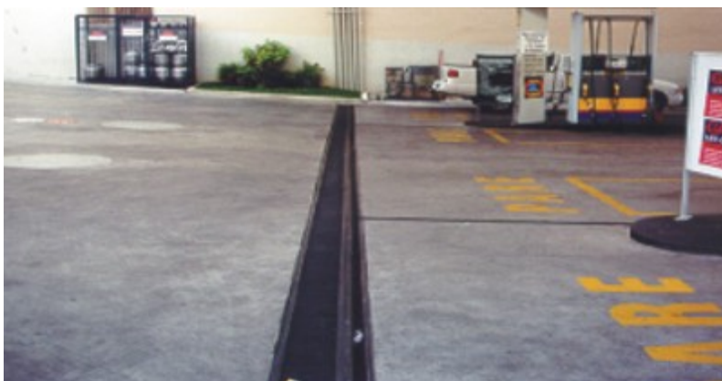
Figura 12. Canaleta (Fonte: ROCHE, 2003)
