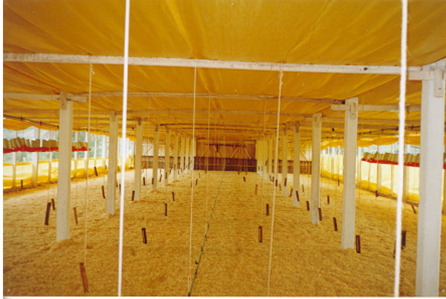
Foto 01 - Aviário destinado para o alojamento de aves.
