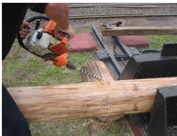
Figura 21 – Furos representando o retratamento da PRESCHEM (2004).
