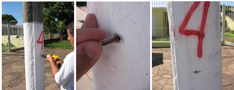
Figura 46 – Aplicação dos TAGs em postes de concreto.
