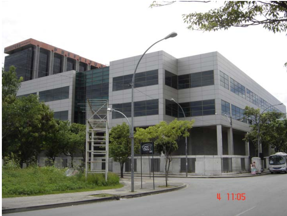
Figura 84: Vista do edifício comercial. Na foto, pode-se ver os tapumes contornado a edificação pronta. Foto: Claudia Baima - fev/07.
