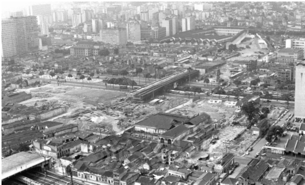
Figura 28: Vista da construção do Viaduto de São Sebastião sobre a Avenida Presidente. Grande parte da Rua Marquês da Sapucaí foi demolida. Fonte: Arquivo O Globo - 25.02.1970
