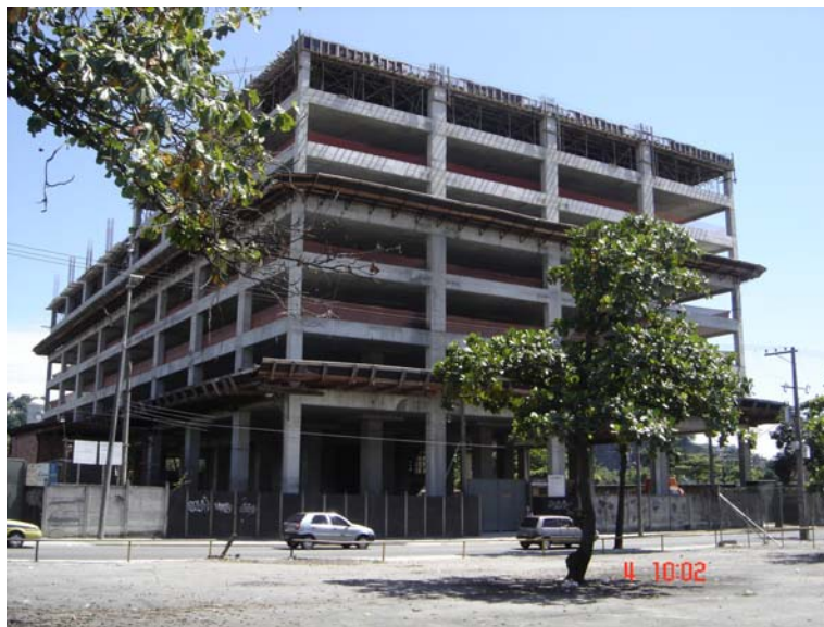
Figura 95: Vista do edifício inteligente em construção. Foto: Claudia Baima – fev/07
