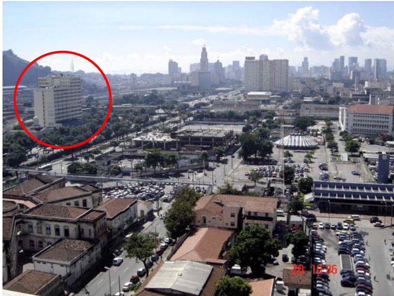
Figura 97: No destaque, vista do edifício ocupado pela Universidade Estácio de Sá na Avenida Presidente Vargas. Foto: Claudia Baima – out/06
