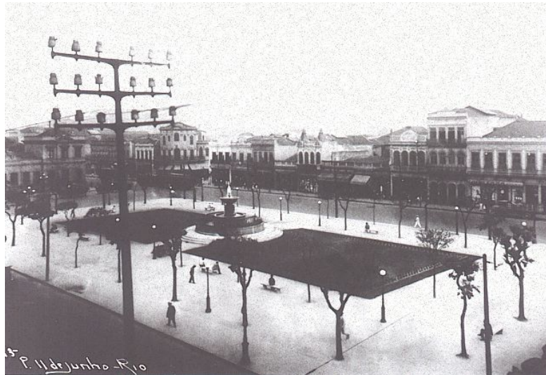
Figura 21. Casarios do entorno da praça. Ao centro, ainda se observa o chafariz, que atualmente se encontra no Alto da Boa Vista.
