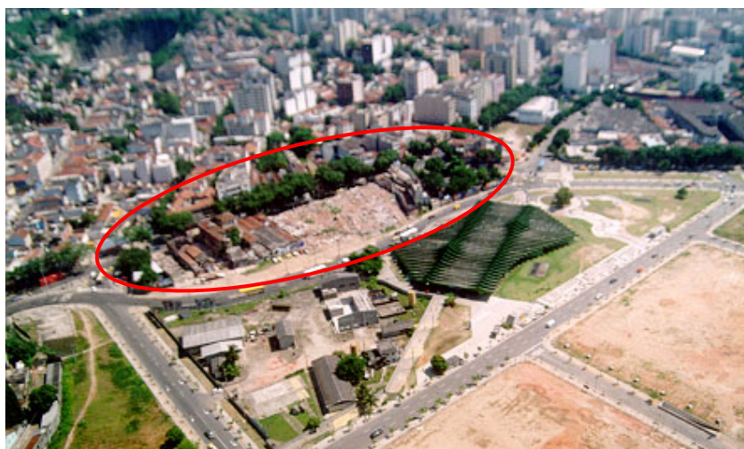
Figura 80: No detalhe, vista da área que foi demolida para a duplicação da rua Estácio de Sá e para a implantação do parque junto à estação do metrô Estácio.
