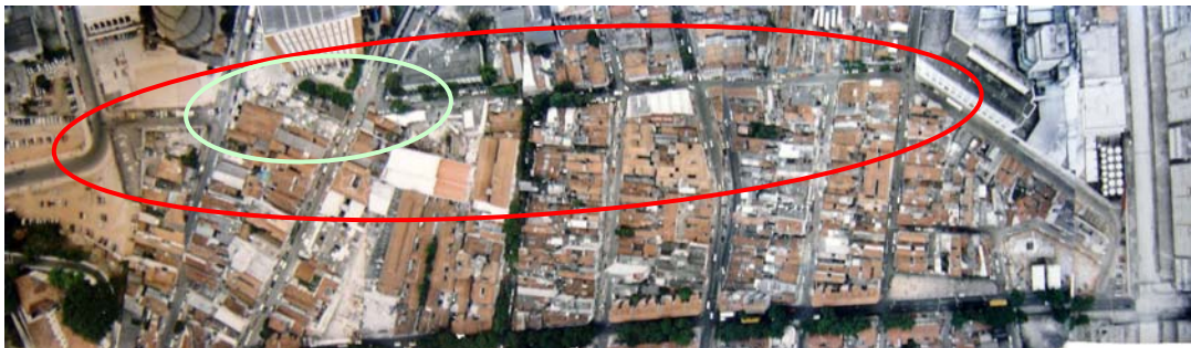
Figura 71: No destaque em vermelho, da esquerda para a direita, as Ruas São Martinho, Santa e Rodrigues dos Santos. No destaque menor, a proposta de abertura de via. Foto: Levantamento aéreo 1998/99 – material cedido por Carlos Fernandes de Andrade.
