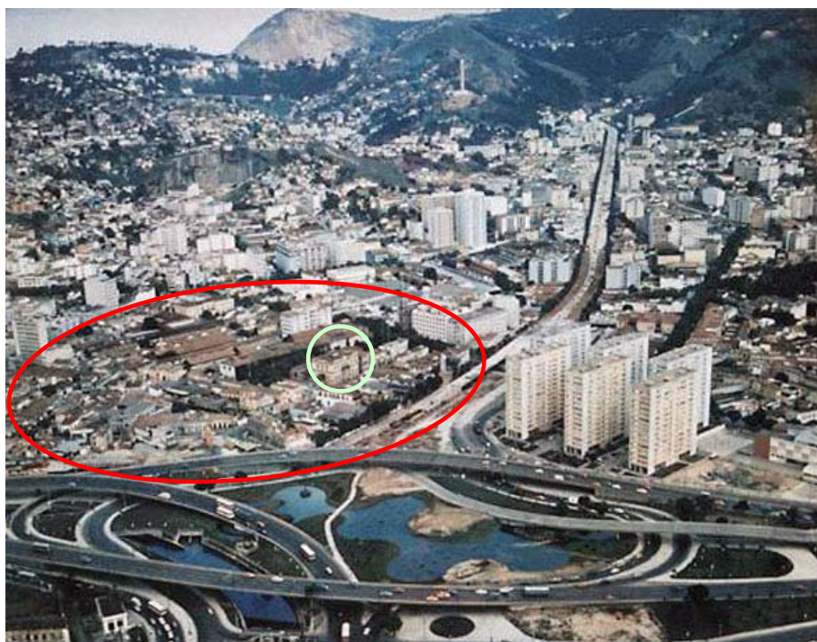
Figura 78: No destaque em vermelho, vista da área que foi demolida com a justificativa da requalificação do espaço urbano. No detalhe menor, o prédio da TV Rio.
