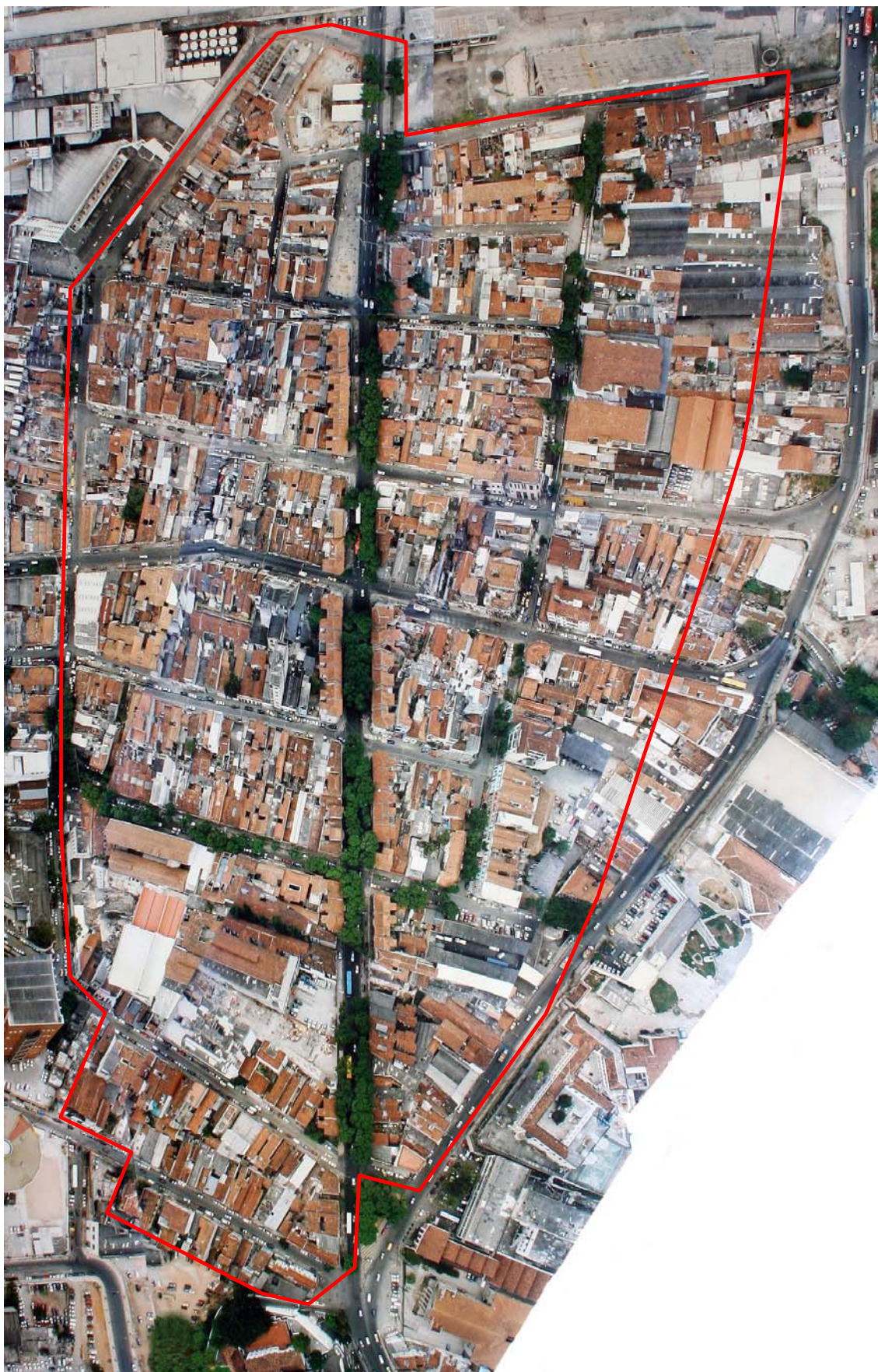
Figura 55: Levantamento aéreo da área da APAC da Cidade Nova Fonte: Vão aéreo entre 1998/99 - Carlos Fernando Andrade
