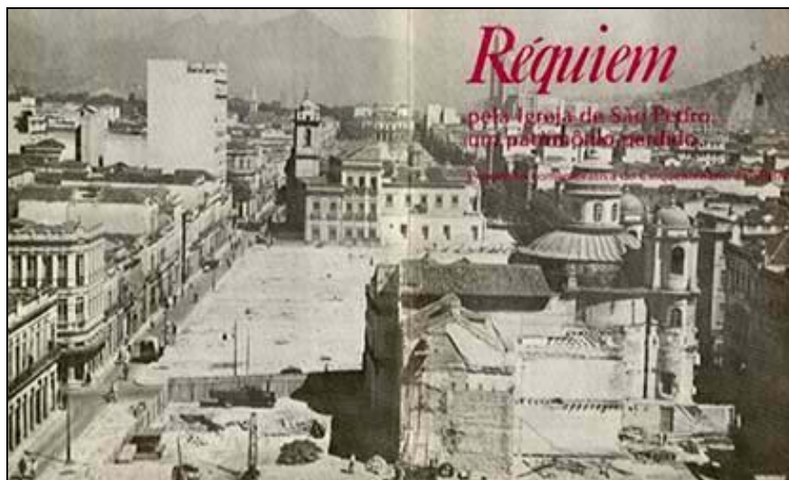
Figura 19: Abertura da Avenida Presidente Vargas, mostrando em primeiro plano a demolição da Igreja de São Pedro dos Clérigos. Folheto de propaganda de uma exposição. Réquiem pela Igreja de São Pedro, um patrimônio perdido.
