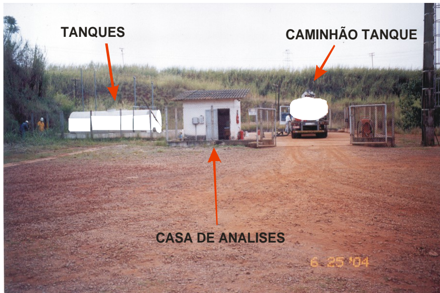
Foto 2.1: Foto da área “A” - Tanques de armazenamento de combustíveis.
