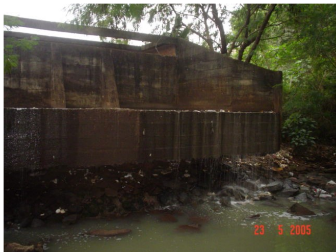
Figura 28. Plataforma de despejo de esgoto ribeirão mandacarú , maio de 2005
