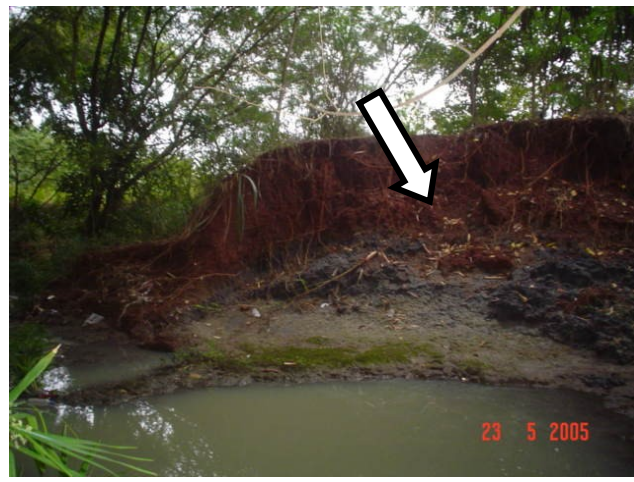
Figura 27. Degradação das margens da nascente do ribeirão Mandacarú - maio de 2005
