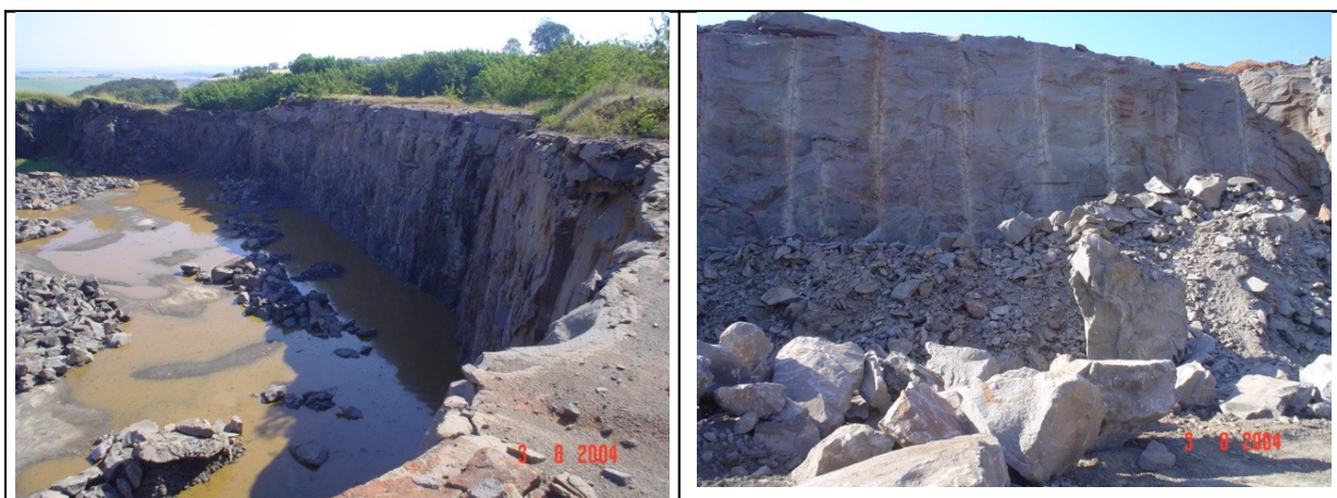
Figura 23. Visualização da pedreira da prefeitura municipal de Maringá, paredão vertical de exploração de brita
