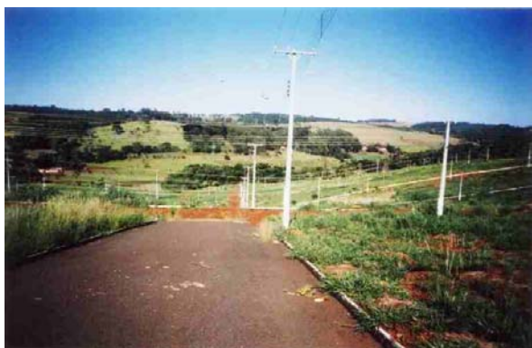
Loteamento "Residencial Interlagos" situado na passagem do C1 para o C5. Fortes declividades nos sopés onde o arruamento encontra-se perpendicular ao nível de base local, ocasionando sérios problemas de transporte de material e assoreamento das áreas rebaixadas.
